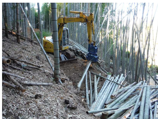
○バンブーカッター造材状況
